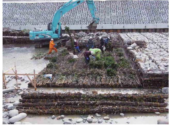
河川を閉め切って粗朶沈床を施工している現場(長良川:岐阜市)
