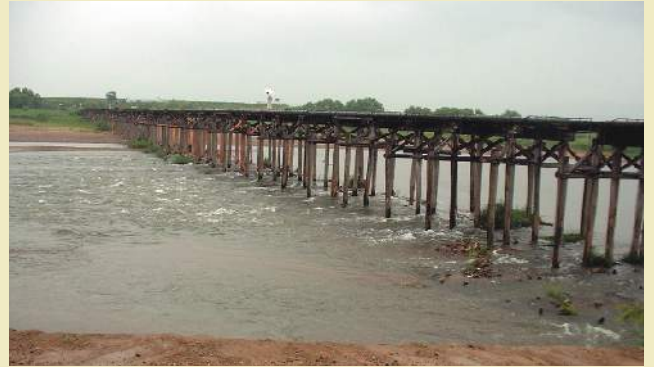
上津屋橋（流れ橋） 京都府南部を流れる木津川に架けられた日本で最も長い木造橋 2003年6月14日撮影
