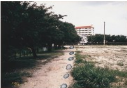
4 造成工事着工前の風景。中央の6個の点は旧五六川の位置で、着工当時暗渠になっていた
