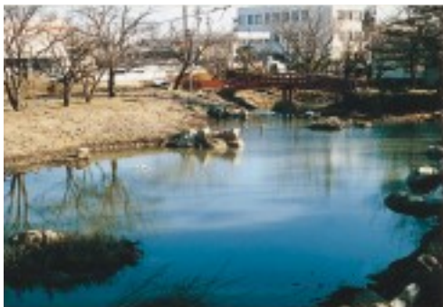
8 涸れていた池の改修工事
