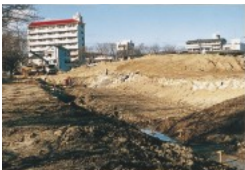
10 五六川の改修と同時に、右手東側に築山を造成中
