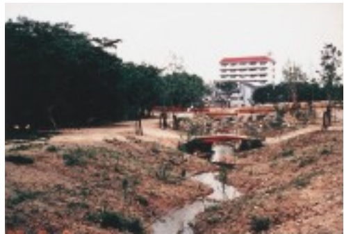
5 五六川復活工事中
