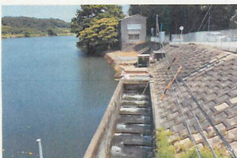
明治用水頭首工左岸魚道
