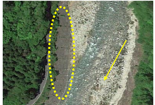
写真4 2016年の下流300m付近の空中写真
