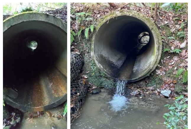
写真 2 吉田川 コンクリート製パイプカルバート (左・下流側 右・上流側)
