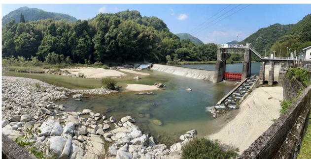
写真1 下切町菅戸ダム直下流の写真
