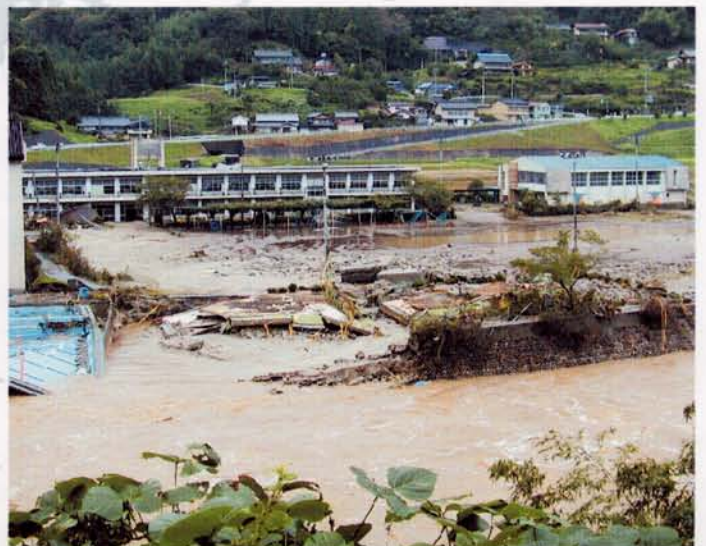
被災した小渡幼稚園(東加茂郡旭町)の跡 2000.9.12
