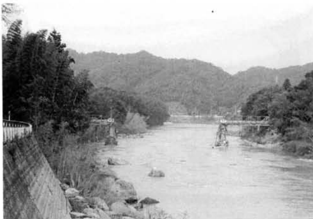
中央部分が流された富国橋。支川の犬伏川が合流する少し上流にかかる橋で、川沿いの民家は床上浸水の被害にあった。(2000.9.22)
