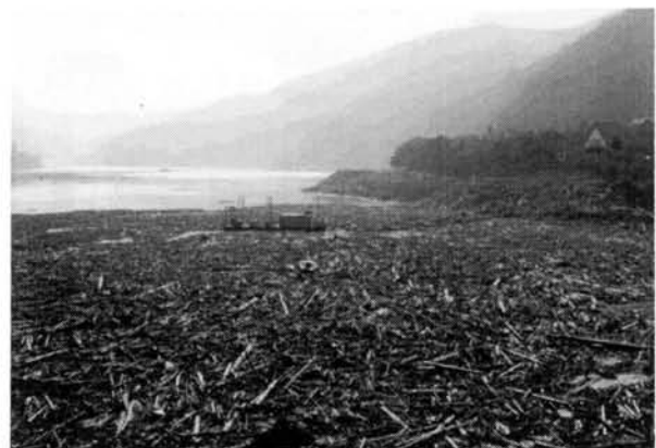
流木に湖面を埋め尽くされた矢作ダム (2000.9.12)
