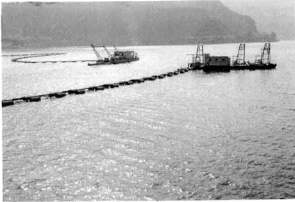
矢作ダム湖のサンドポンプ船。湖底の土砂を吸い上げ、両岸の砂利生産基地へ送る。
