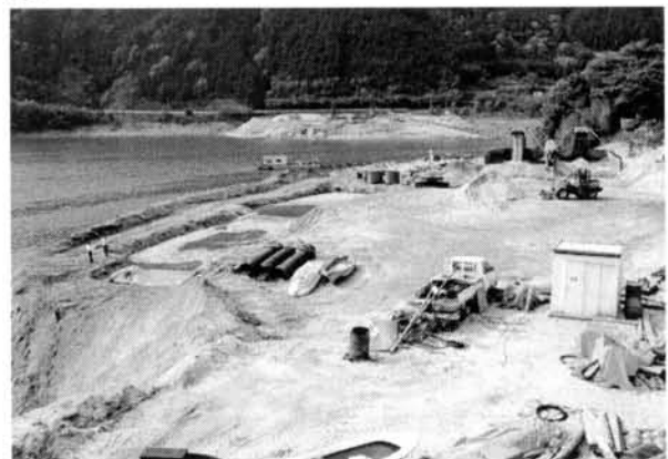
砂利生産基地。ここでコンクリート骨材用の砂利とヘドロが分離される。
