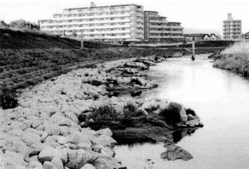
矢作川水系籠川で近年施工された近自然（多自然）型の護岸工事
