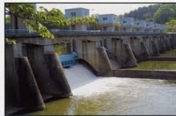
明治用水頭首工
