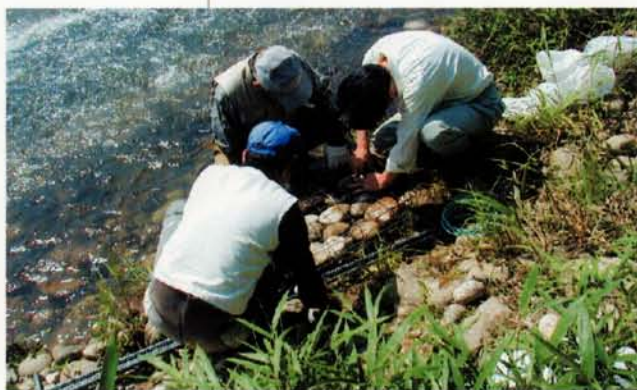
石の設置作業
