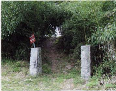
写真1 公園側から堤防道路を見る。 石柱中央に板をはめる溝が見える。
