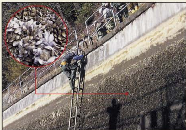
図1 越戸発電所導水路
