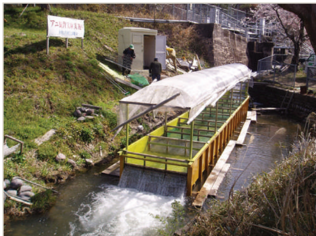
写真 越戸ダム魚道に設置したアユの実験施設
