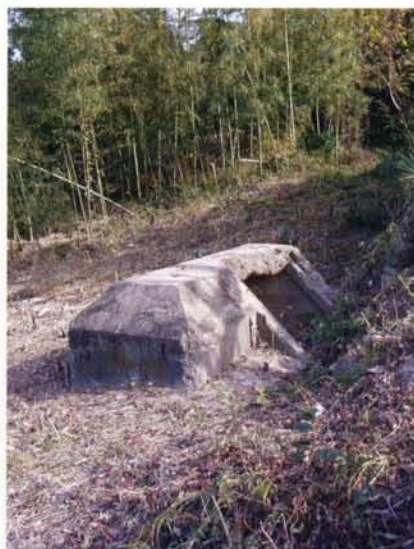
打ち捨てられた揚水ポンプ場
