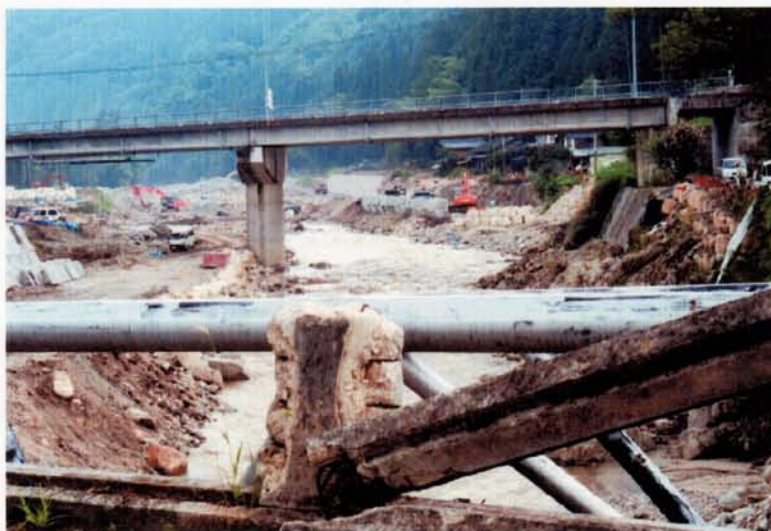
上村川(澄ヶ瀬付近)復旧工事の様子 2001.7.27 内田朝子 撮影
