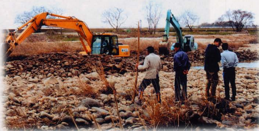
古川での工事風景 2001年3月31日 撮影
