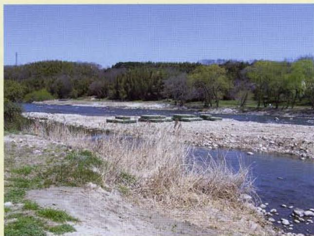
越戸の中州先端に施工されたハイドロバリア水制
