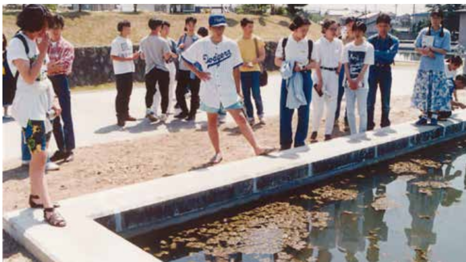
図1 緩速ろ過池では藻が浮いていた
