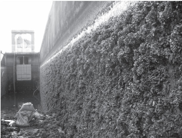
図3 利根川下流域の利水施設(沈砂池)に大発生したカワヒバリガイ。
