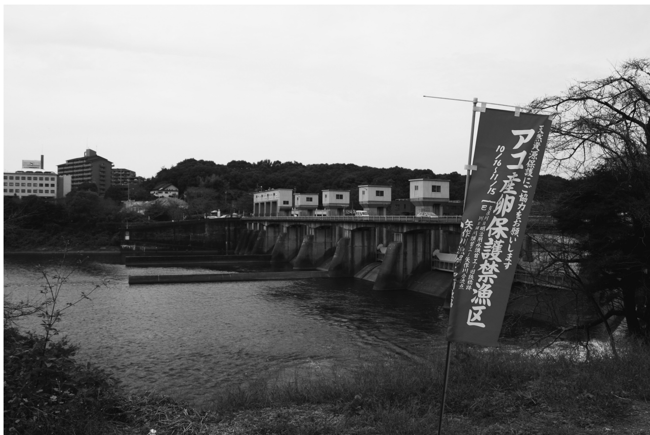
矢作川最下流の農業用水ダム・明治用水頭首工。最近では天然アユの稚魚遡上量観測施設、遡上稚魚の上流へのトラック輸送基地、人工産卵場などの多目的に利用されている。
