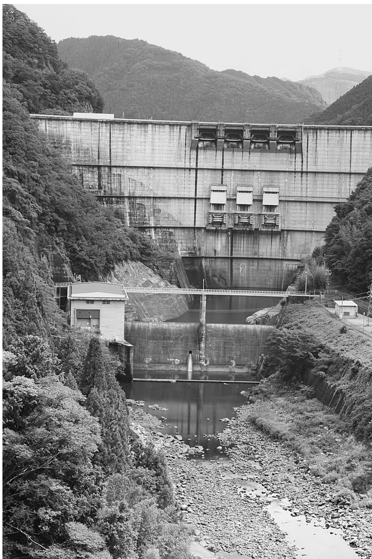
総貯水量800万トンの矢作ダム。春の天然アユ稚魚遡上期、秋の仔魚降下期にダム湖の環境容量を放出する。
