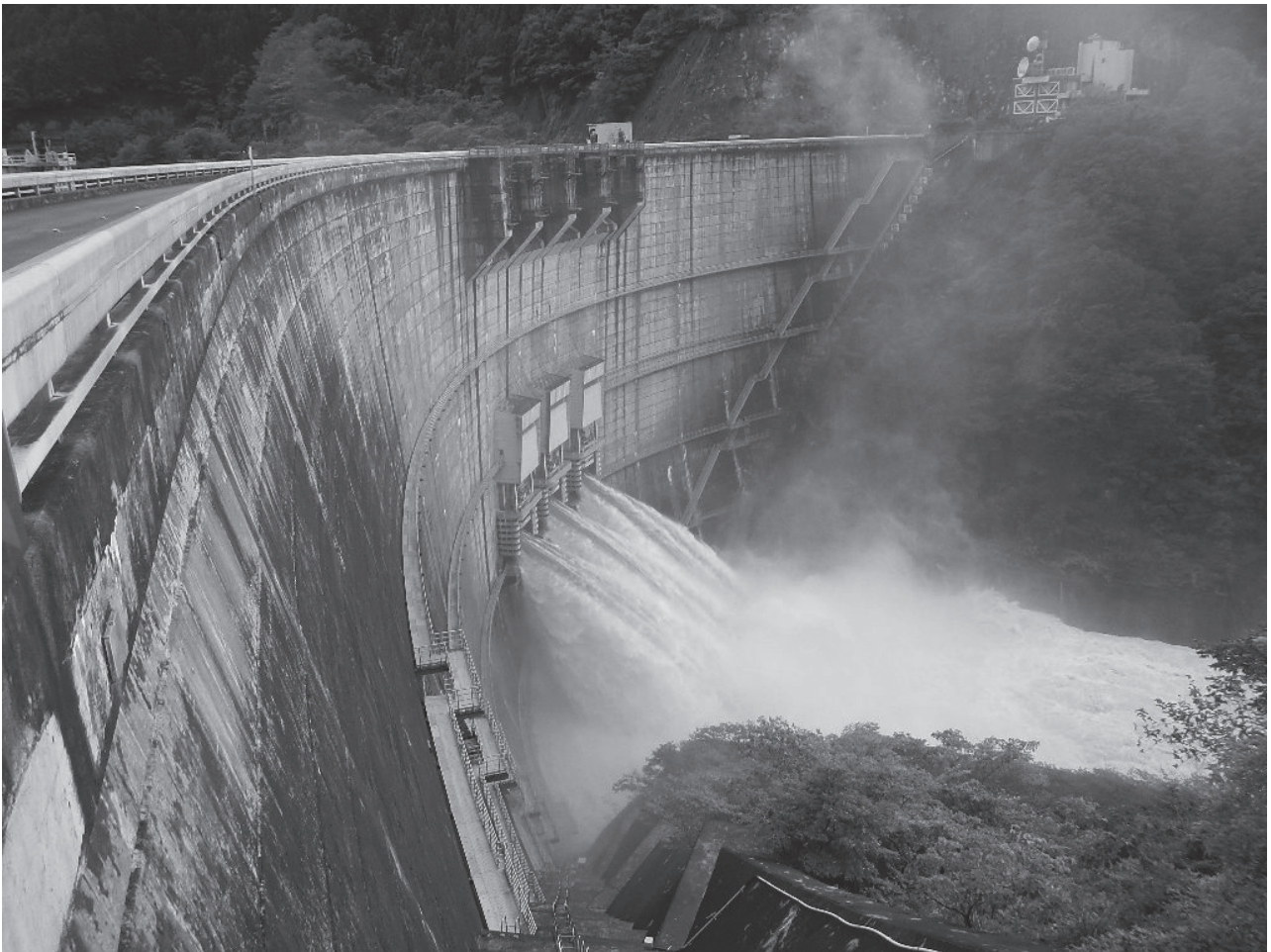
写真 2013年9月16日の台風16号の際の矢作ダムは毎秒1000トンの洪水を常用洪水ゲートから放流した。矢作川的环境派はダム洪水放流の「環境プラス効果」を調査し、記録に残さなければならない。
