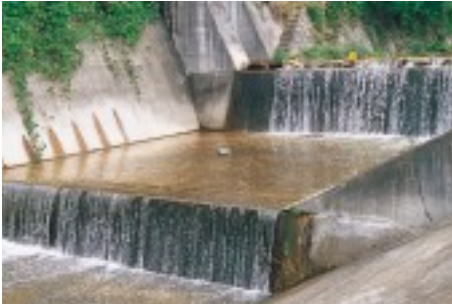
写真27 御船川には各所にこのような落差溝があり魚類の遡上を妨げている
