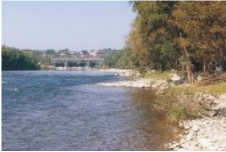
写真1 古岸水辺公園から平戸橋を望む
