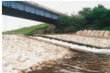
写真14 籠川に新設された超激流の魚道（荒川橋下）
