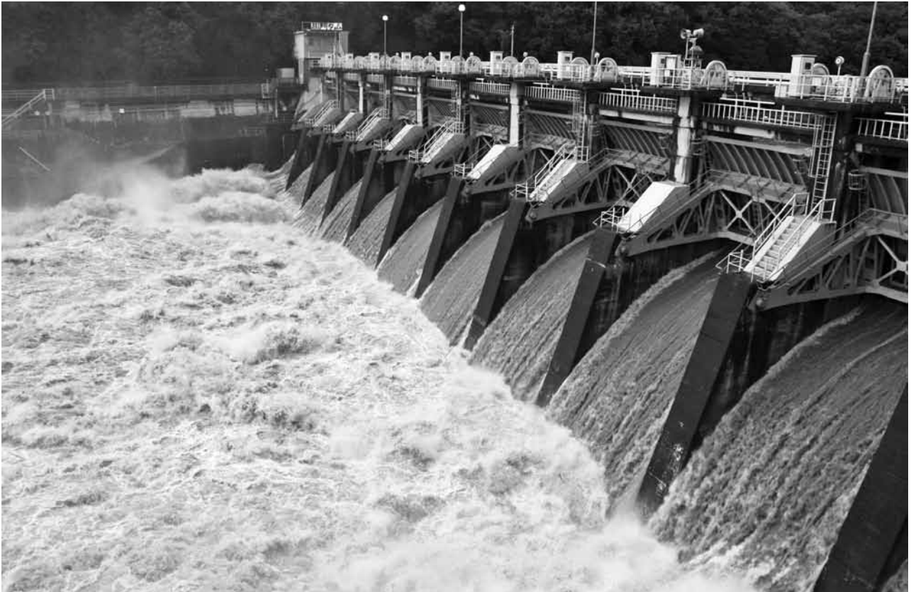
写真 河口から45km地点にある中電越戸ダム、堤高22m、堤長120m。2011（平成23）年9月21日、台風15号の出水で12門のゲートを開き最大毎秒1206トンの洪水を放流していた。こうしたゲート放流でダム湖底の砂・小石・玉石が放出されるかどうかに関心事だ。ここに「ダム研究」の中心的課題があると思われる。
