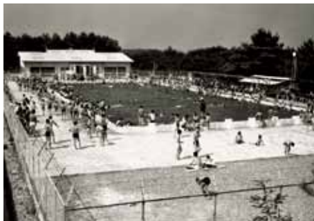
写真1 毘森公園プール写真(豊田市役所蔵)。
