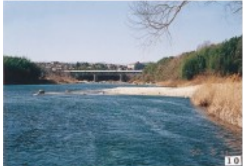
写真 10 砂利を緩傾斜で押しだし始めた頃の No. 0 地点。(1997.3.11, 扶桑町)
