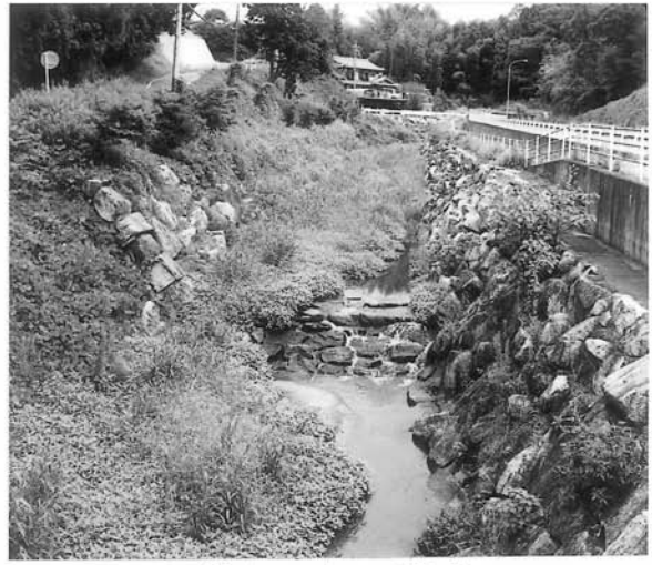
4. St. 26 : 勘八町 (一の瀬川)
