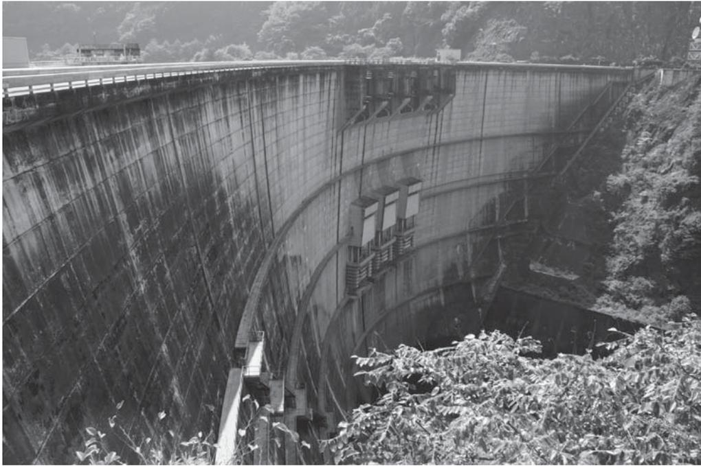
写真1 矢作ダム 1971年建設省が建設した多目的の矢作ダム。稚魚遡上用の「遡上魚道」も、産卵親魚が産卵場へ下る「降下魚道」も設置されていない。矢作川漁協がトラック輸送で天然アユ稚魚のダム越え実験事業に成功したことがあるが、ダム管理者はそういうミティゲーション措置も採用していない。今も利水・治水本位の構造・運用であり、矢作川の様々な河川環境管理の障害になっている。
