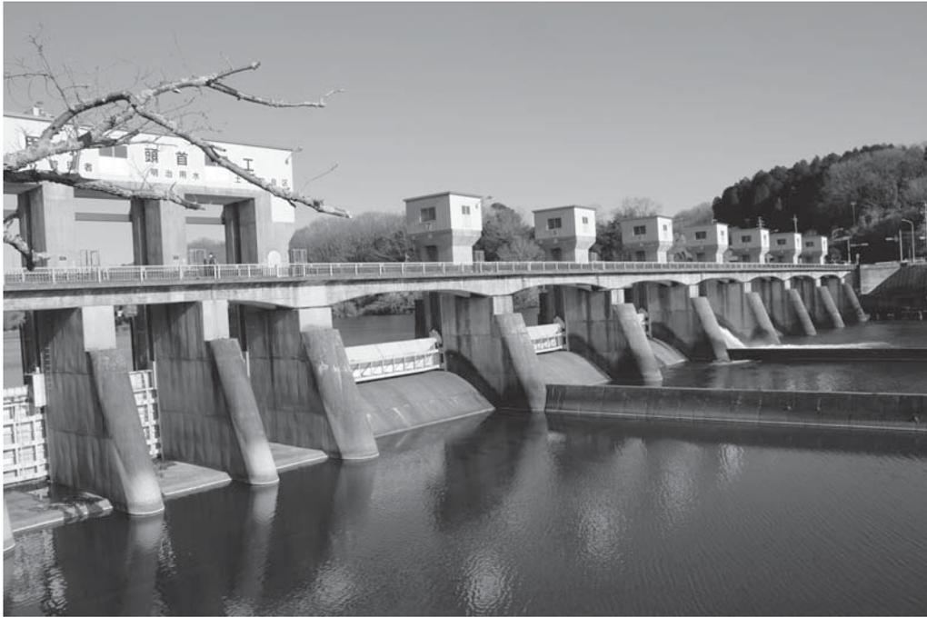
**写真3** 明治ダム 1958年明治用水土地改良区が建設した農業用水専用の明治用水新頭首工，略称明治ダム，矢作川最下流のダム（今では工水兼用）であり，大量の天然アユの稚魚が集まる．右岸魚道には漁協の稚魚捕獲施設があり，ここからトラック輸送で稚魚が上流各所に分散放流される．ダム河川の矢作川で良好な自然遡上が困難なのだ．左岸魚道には豊田市矢作川研究所の天然アユ遡上調査場がある．優良構造の降下魚道もあるが，魚道閉閑操作が今は困難だ．近くダムの耐震改造のなかで改良予定．明治期以来，農・漁の紛争の場所だった「明治ダム」が農・漁協力の象徴的存在になってきた．
