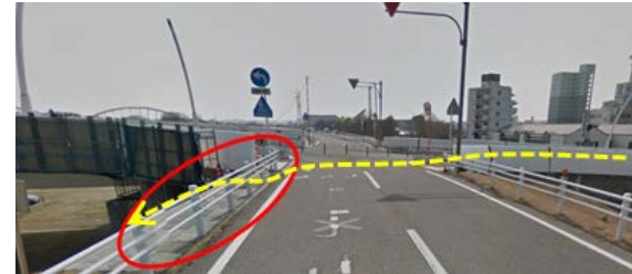
人の動線を遮る道路柵の例
