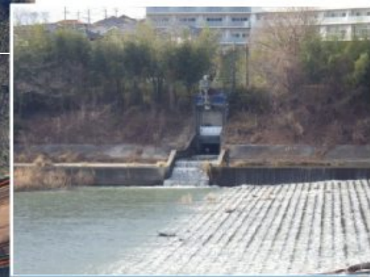
一級河川現安永川 現在の合流部は大きな落差により分断しているが、新安永川では分散型落差工による魚道を設置し、遡行が出来るよう改良した
