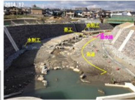
魚道最下流：分散型落差工（施工中） 帯工部：魚が隠れる隙間を作る 水衝部（水が強く当たる）：水制工を設置
