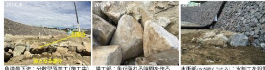
魚道最下流：分散型落差工（施工中） 帯工部：魚が隠れる隙間を作る 水衝部（水が強く当たる）：水制工を設置
