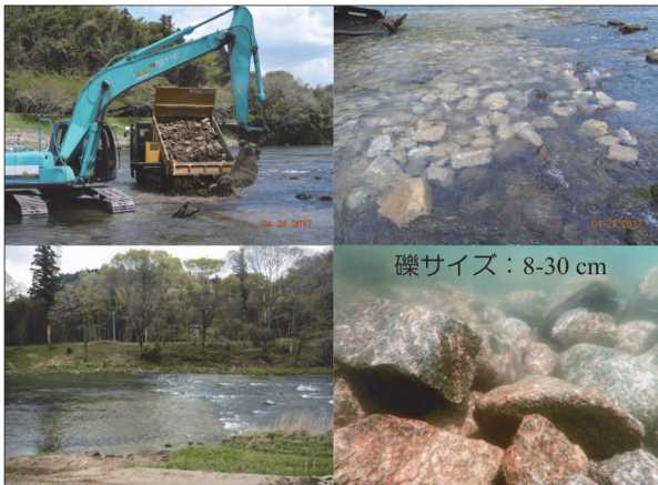
図17 礫置実験区の造成時の様子。
